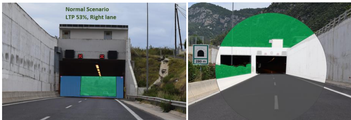
Σχήμα 12. Χρήση κατάλληλων φωτογραφιών για τον καθορισμό των αναγκών του ημερήσιου φωτισμού στις σήραγγες μικρού μήκους διέλευσης οχημάτων της Περιφέρειας.
